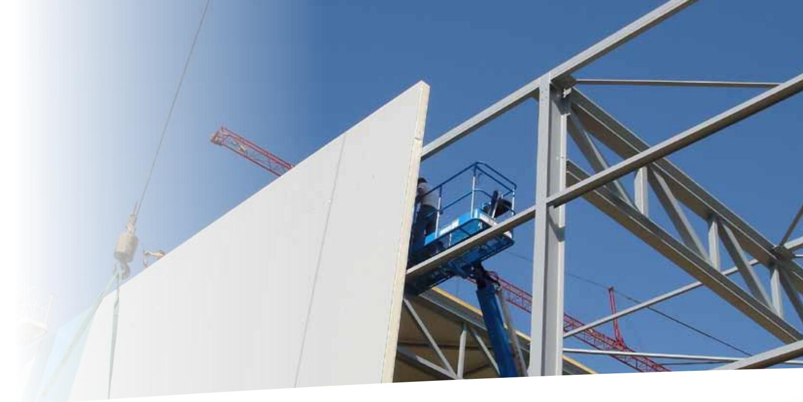
панели могут обеспечить безопасную, пригодную для ходьбы платформу для работ, в отличие от систем, которые собираются на месте работ, где сперва устанавливается хрупкая обивка крыши, а затем приступают к сборке многочисленных элементов таких систем.
