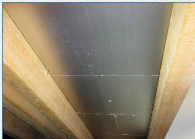
Foto 1: Intradosso del tetto a falde con lo strato isolante a vista tra i travetti
