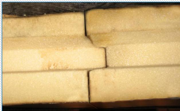
Foto 3: L'accostamento tra i pannelli con battentatura laterale
