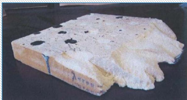
Fotografia 5: Próbką PU zdjętą z dachu płaskiego
