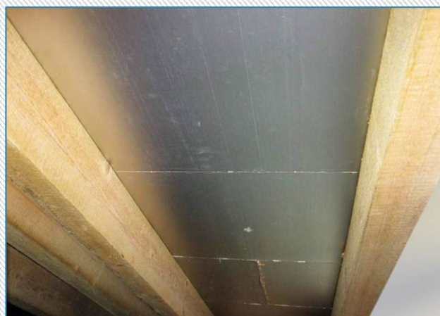
Fotografia 1: Strona wewnętrzna skośnego dachu z krokiewiami i warstwą izolacji
