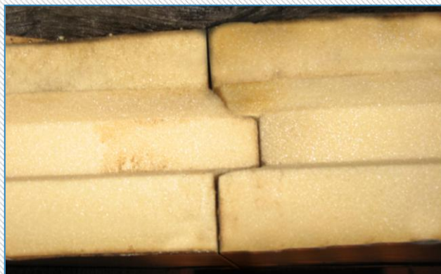
Fotografia 3: Płyty izolacyjne zamontowane szczelnie (ciasno) koło siebie
