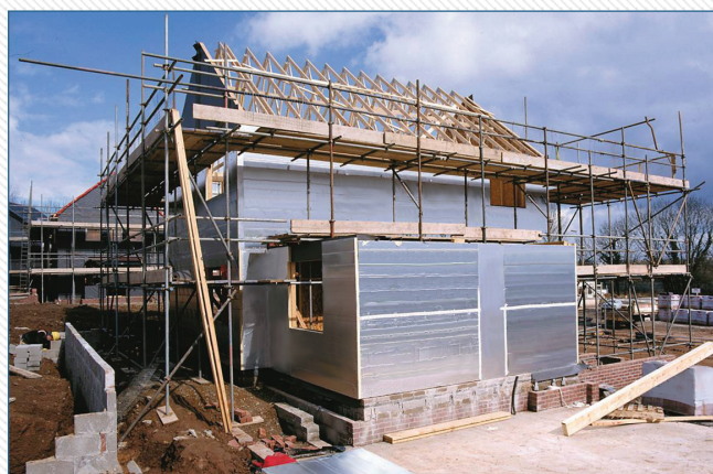
Ilustracja 1: Budowa drewnianej konstrukcji szkieletowej
