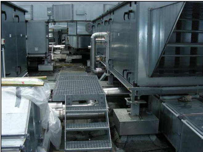
Abbildung 1 und 2: Mit Klimaaggregaten überbaute Dachfläche
