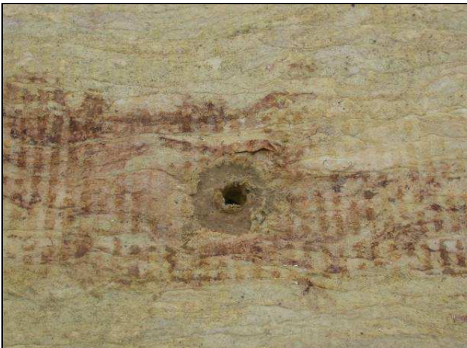
Abbildung 16 und 17: Probestelle im Bereich einer Kehle mit lang anhaltend stehendem Wasser
