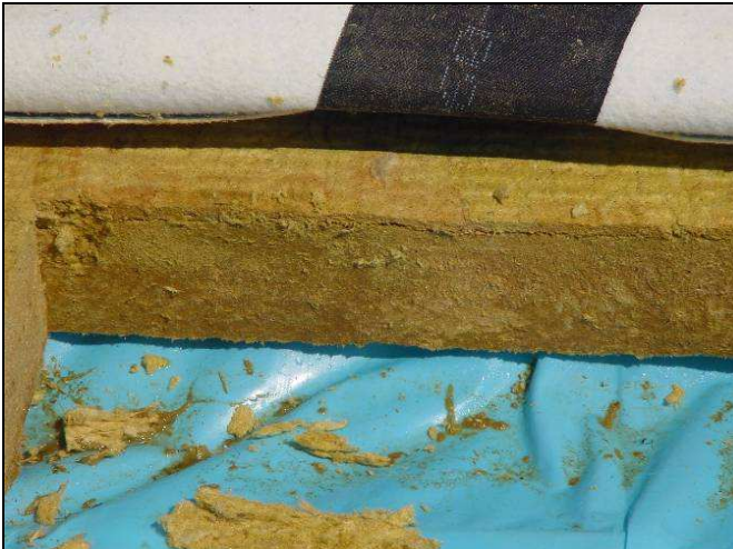
Abbildung 12 und 13: Öffnungsstelle mit durchfeuchtetem Dämmstoff, der über einer 4 mm tiefen Pfütze auf der Dampfsperre liegt.
