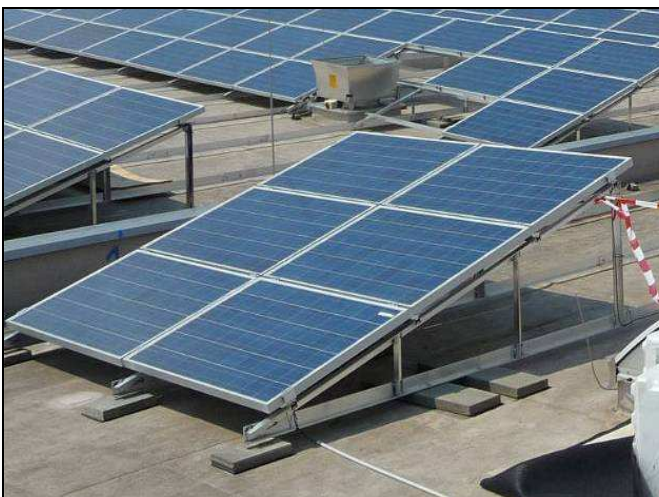
Abbildung 4 und 5: Aufständigung der Fotovoltaik-Elemente (Foto: LGA) und Dachfläche nach Abräumen der Elemente.
