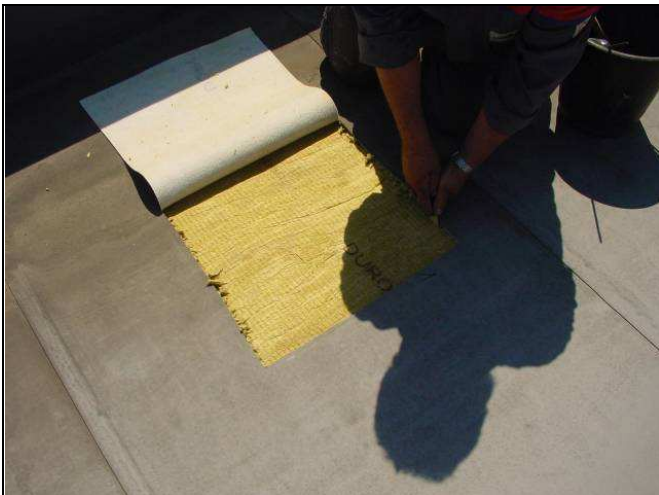
Abbildung 14 und 15: Probestelle mit Tauwasser auf der Dampfsperffolie
