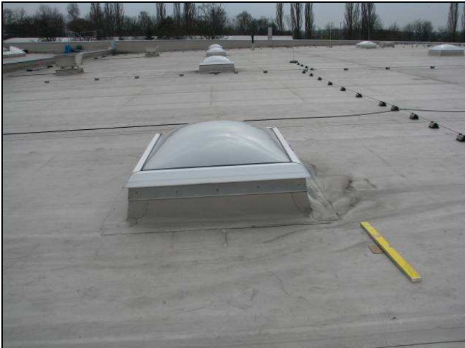
Abbildung 6 und 7: An besonders weichen Stellen wurden Verformungsmessungen mit Hilfe einer Hartfaserplatte und einem Rechteckrohr (Wasserwaage) durchgeführt. Rechts eine relativ große Verformungstiefe von ca. 33 mm.
