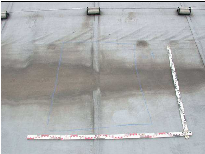
Abbildung 16 und 17: Probestelle im Bereich einer Kehle mit lang anhaltend stehendem Wasser
