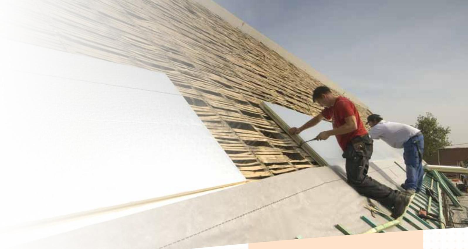
климата, вопрос толщины становится настоящей проблемой, т.к. очень большая толщина изоляции вызывает негативные последствия для наших зданий. Например, стены должны быть шире, что занимает ценное пространство, или увеличится опорная поверхность здания, крыши и фундаменты должны быть больше, крепления должны быть длиннее и, в случае деревянного каркаса, стойки должны быть шире. Все это также увеличит строительные затраты.
