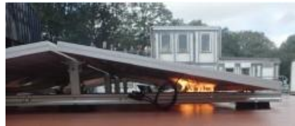
Rysunek 1: Pole paneli PV na dachu płaskim po zapaleniu palnika gazowego
